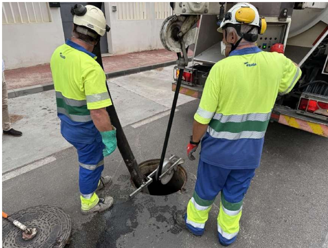
Operarios realizando labores de limpieza de un imbornal.
