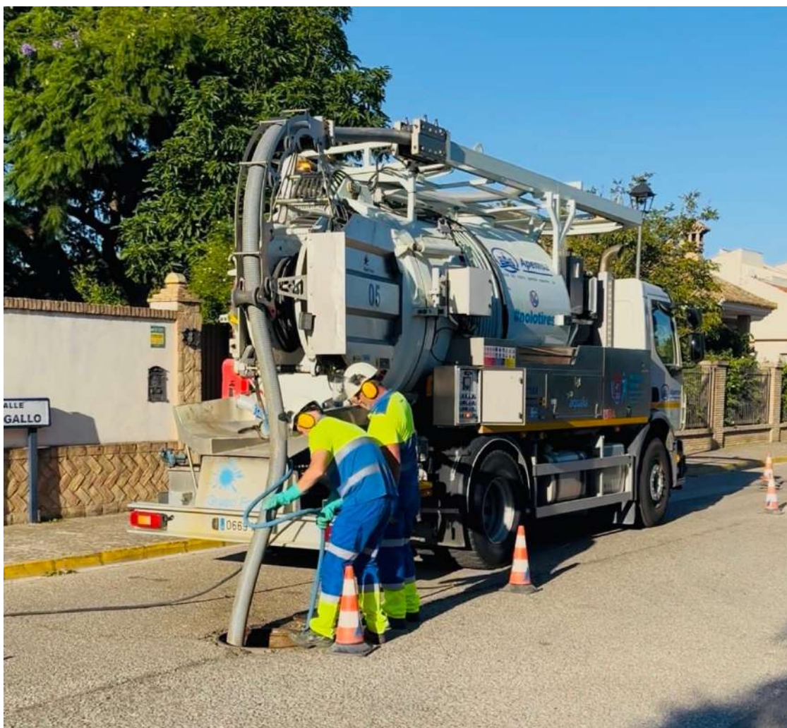
Trabajo en los imbornales de El Puerto | APEMSA
