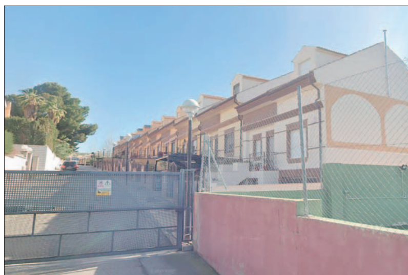
ARCHIVO. Vista de la entrada a la urbanización Vega Alta, en el término municipal de La Guardia de Jaén.
